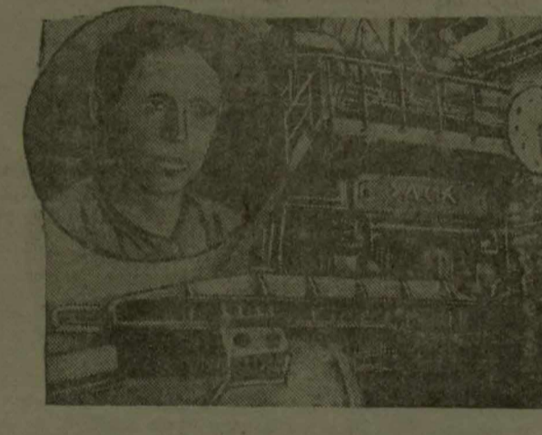
Цех блюминга Кузнецкого комбината. На снимке: стан 1100. Слева — в овале — лущий вальцовщик цеха тов. Сомов. Фото В. Шевякова.
