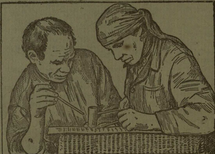
Рабочий Трудоармейской МТС, Киселевского района тов. Ф. О. Верещагин, занятый на ремонте радиаторов, готовит себе смену. Он решил обучить своему мастерству бывшую уборщицу конторы А. Н. Ушенко. На снимке: т. Ушенко А. Н. паяет трубку радиатора под наблюдением тов. Верещагина.
